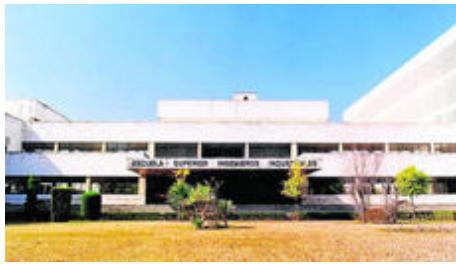
Figura 25. Escuela de Ingenieros Industriales en Sevilla en 1975.
